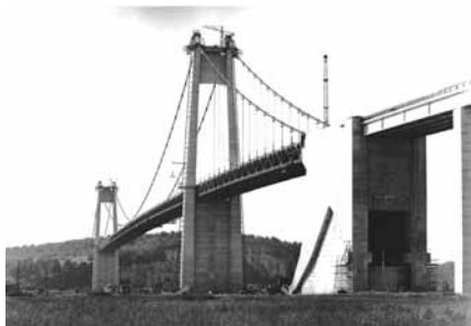
Pont de Tancarville en construction (1956). Mis en service le 2 juillet 1959, cet ouvrage sur la Seine marque le retour en grâce des ponts et... routes à péage en France
