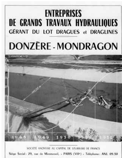
Les Entreprises de Grands Travaux Electriques (EGHT), gérant du lot dragues et Draglines. ©La Houille Blanche Donzère-Mondragon
