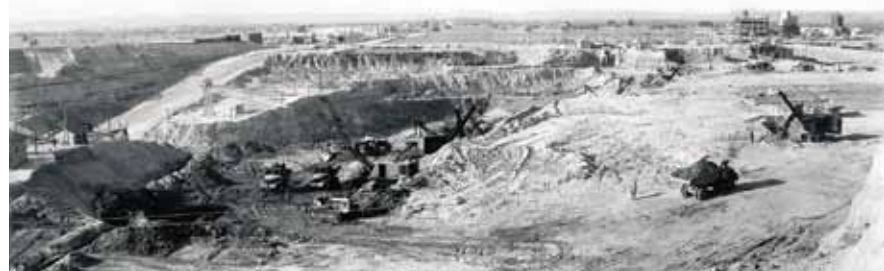
Janvier 1949 : le chantier de Donzère-Mondragon est en pleine activité. © A. Berthonnet/Chagnaud
