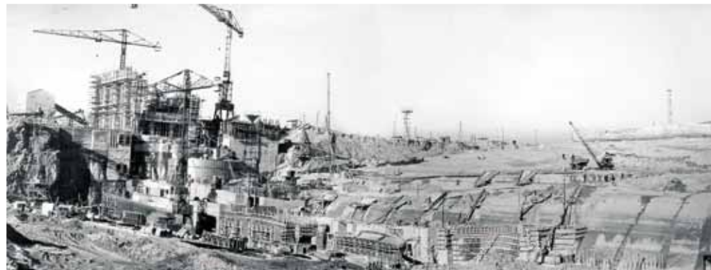
Donzère-Mondragon : vue panoramique des six groupes et du déchargeur. Annexes rive droite, hall de montage en construction (12 janvier 1950). En quelques mois, le chantier connaît une mécanisation des moyens de production. © A. Berthonnnet/Chagnaud
