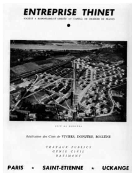
L'entreprise Thinet participe à la construction de trois des sept cités qui vont loger l'ensemble des ouvriers et de nombreuses familles.
