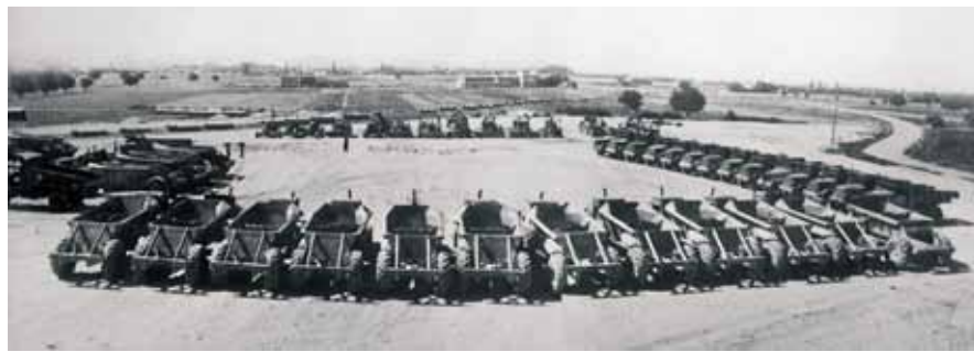
Flotte de camions et de semi-remorques «Euclid» pour le lancement des premiers travaux de terrassement (20 juillet 1948). A Donzère-Mondragon, les camions ont supplanté définitivement la voie ferrée et les wagonnets. © A. Berthonnet/Chagnaud
